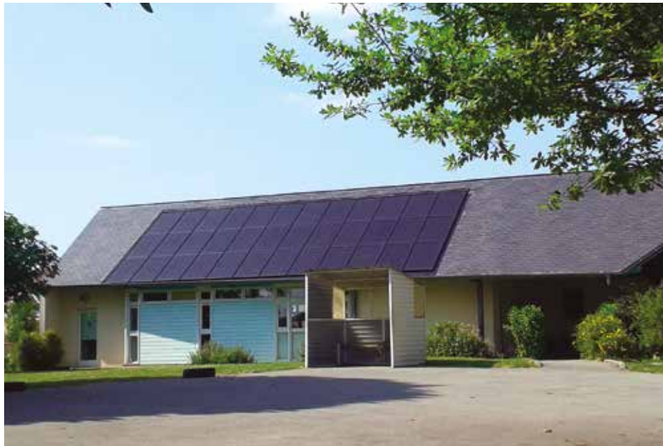
Centrale photovoltaïque sur l'école de RIUPEYROUS.
