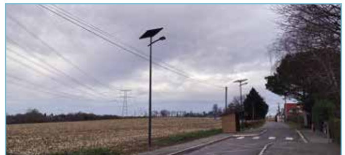
Éclairage public solaire à Saint-Arrou
