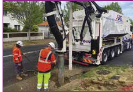
Enfouissement rue Louis de Foix à BAYONNE
