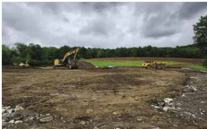
Chantier en cours à BENEJACQ
