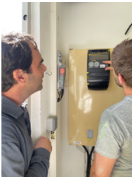
Mise en service de la centrale
