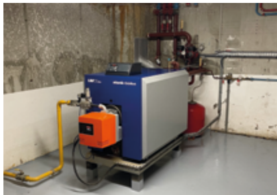
Des fonctionnements de chaudières à optimiser
