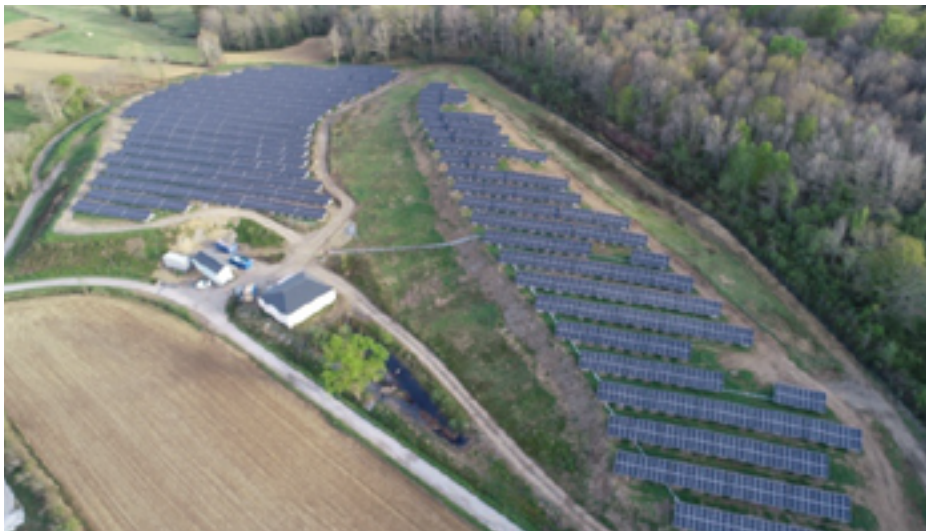
La centrale de Bénéjacq vue du ciel
