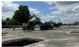
Stade de BORDES (en cours de travaux)
